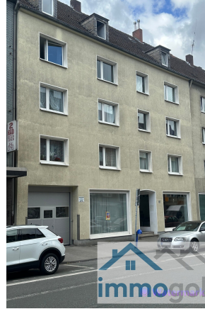
Haus Straßenansicht schräg
